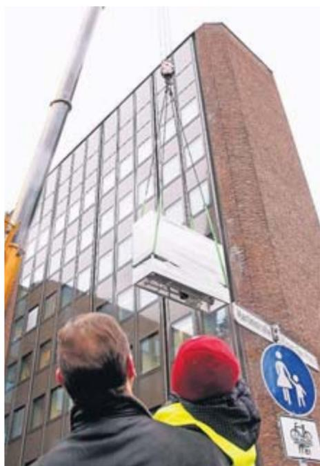
Heinz Rühl (Firma Rühl Haustechnik) verfolgt mit seinem Enkel Leonard, wie das neue Blockheizkraftwerk per Schwerlastkran in Richtung Rathaus-Obergeschoss schwebt.
